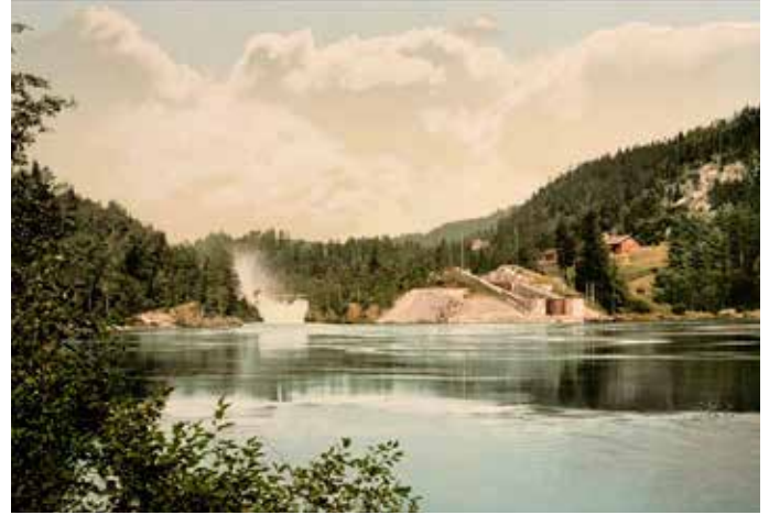
Dette er et gammelt bilde fra Løveid sluser, men slusene er de samme i dag.
